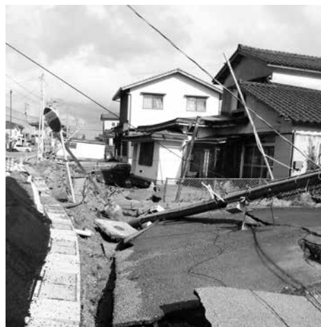
壊滅的な被害を受けた内灘町北部地区
