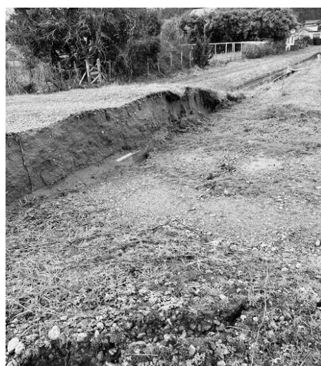
70センチの隆起により大きくずれた水田
